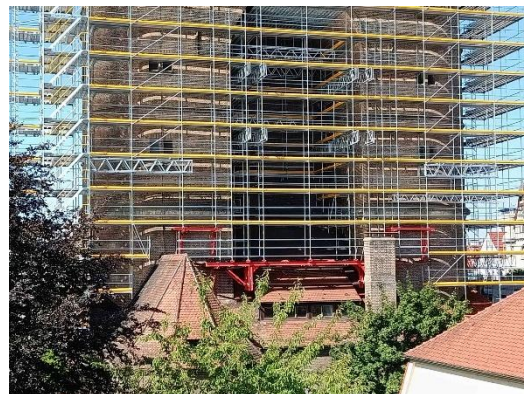
Anfang Juli 2026: Das große Gerüst an der Ostseite der Pauluskirche wächst in die Höhe. Gerüstbau startet am südlichen der beiden Türme im Osten der Kirche und geht dann auf die Hinterseite. Auch der Triumphbogen wird bis nach innen eingerüstet
