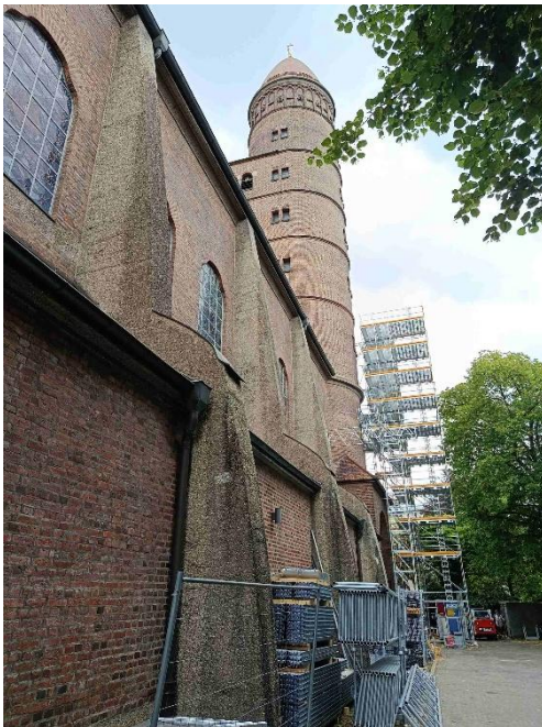
Anfang Juli 2026: Das große Gerüst an der Ostseite der Pauluskirche wächst in die Höhe. Gerüstbau startet am südlichen der beiden Türme im Osten der Kirche und geht dann auf die Hinterseite. Auch der Triumphbogen wird bis nach innen eingerüstet
